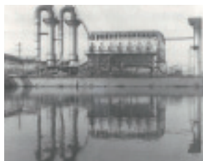
知多工場電気炉集じん装置 (1970年)
