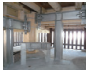
ステンレス間柱とタイロッド受金物
