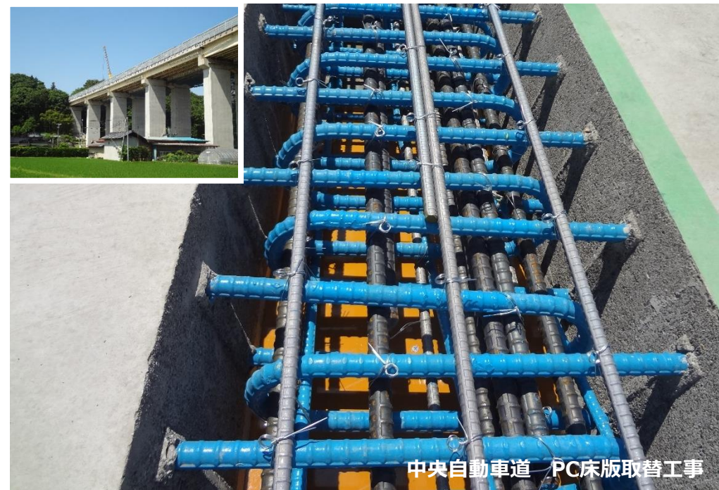
ステンレス鉄筋活用によるインフラ再構築
